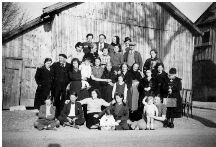
Centre d'accueil de Morteaux 1939
